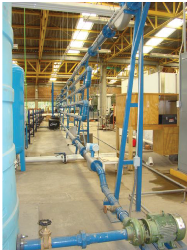
Figura 1. Vista lateral de del ducto piloto
